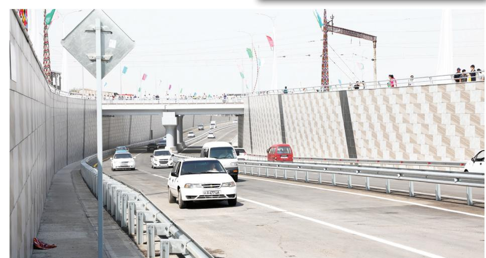
Лойиҳа доирасида объектда жами 7,6 минг кубометр бетон, 104 минг кубометр тупроқ ва 3,4 минг тонна асфальт ётқизиш ишлари олиб борилди. Автомобиль ва темир йўл үтказгичларида 42 та темир-бетон оралиқ қурилма, тоннель шаклидаги йўл үтказгичда 521 та тиргак девор монтаж қилинди, 90 та ёритиш устуни ҳамда 648 метр ҳимоя тўсиклари ўрнатилди.
